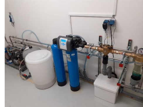
Wasseraufbereitungsanlage (links) und Dampferzeuger (rechts)
