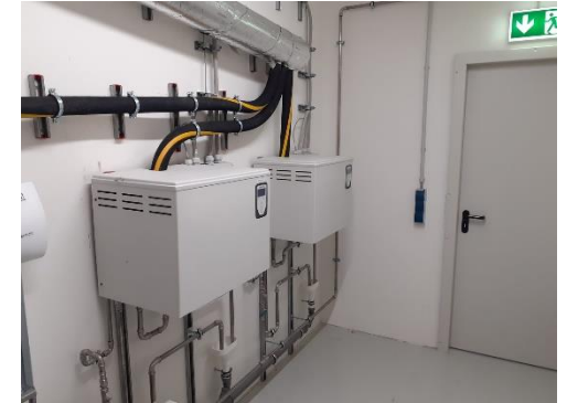
Wasseraufbereitungsanlage (links) und Dampferzeuger (rechts)
